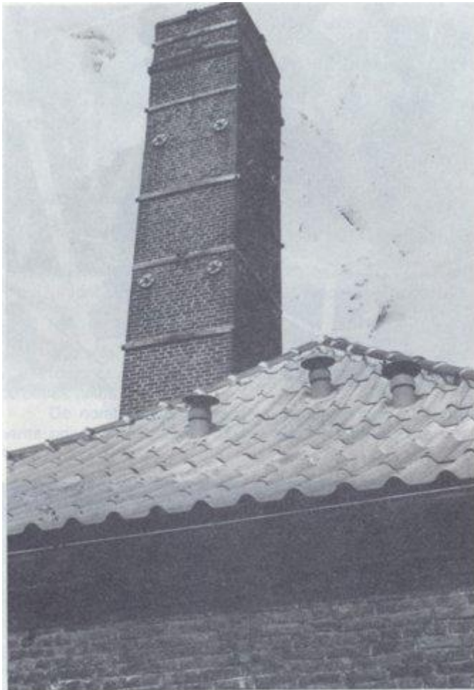
Fig. 8. - Cheminée carrée du XIXème siècle.
